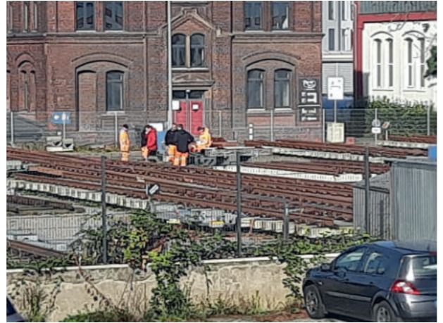
Im „Weichengarten“ an der Wideystraße üben die zukünftigen Weichenmechaniker.
