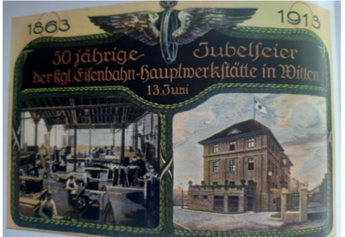
Frühere „Central-Reparatur-Werkstatt“ - rechts im Bild - ist heute das Wittener DB Trainingszentrum zu finden.
